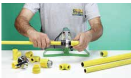
2. Aquecimento do tubo e conexões a 260°C
