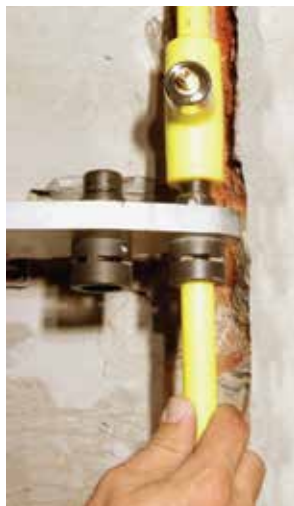
Termofusão do tubo
