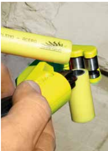
Corte com corta-tubo em obra
